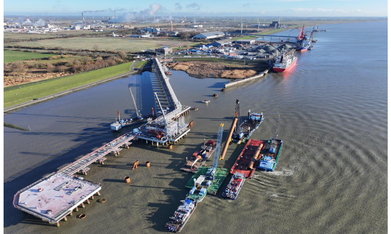
Abb.7: Im Bau befindliche Jetty am Elbehafen
